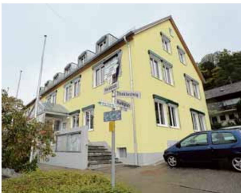
Der Zugang zum Rathaus wird komplett umgestaltet (siehe Grafik oben). Das Treppengeländer und der Schaukasten bleiben erhalten. Archivfoto: Marcus Merk
