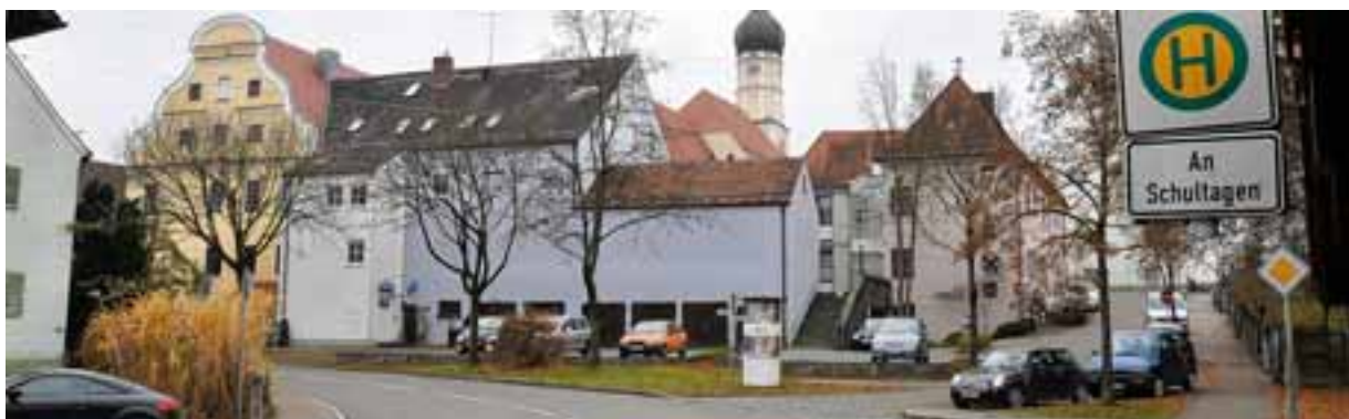
Blick von der Ganghoferstraße auf die Rückseite des Bäckerwirts und die Kirche von Welden. Experte Antonius Janotta sieht auf dem Platz hinter dem Bäckerwirt und in der Ganghoferstraße ein „dringendes Sanierungspotenzial“. Fotos: Andreas Lode
