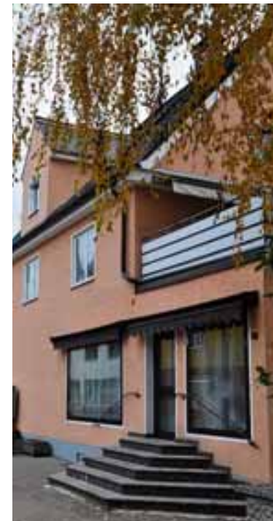
Ein leeres Geschäft in der Ganghoferstraße. Der Fachmann warnt vor einer Abwärtsspirale, wenn weitere Läden schließen.
